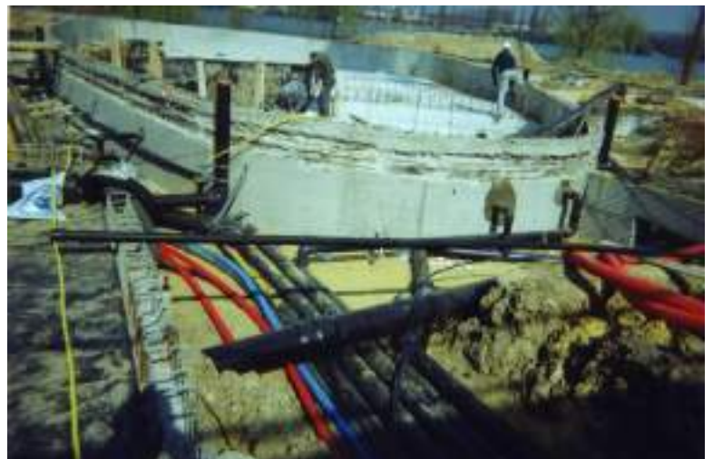
>>>> Mise en place des canalisations bassin extérieur
